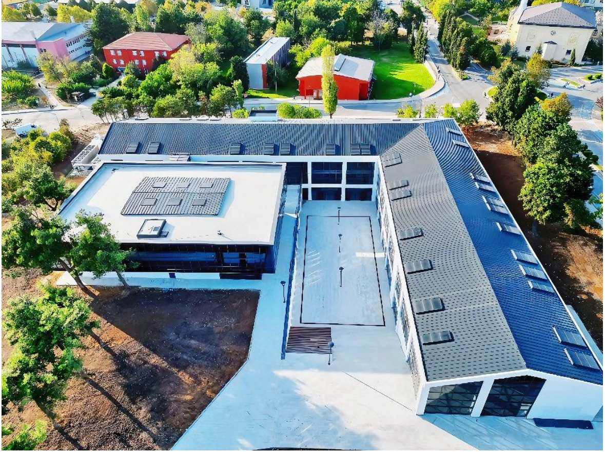
Merkez Kütüphanesi / Davutpaşa Yerleşkesi
